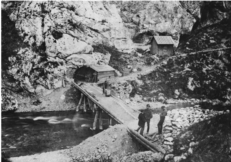
Abb. 2: Stollenbau im Höllental, Foto: Mathias Weingartshofer, um 1870 (Archiv Wiener Wasser)
